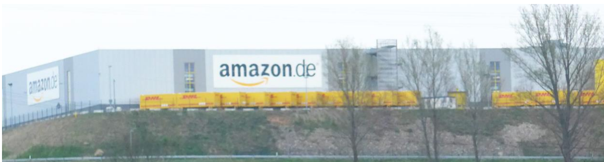
Die Lagerhalle von Amazon in Bad Hersfeld 2014 (Foto privat)
