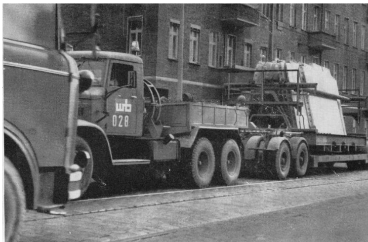
Abbildung 3: Transport von vorgefertigten Bauteilen 71
