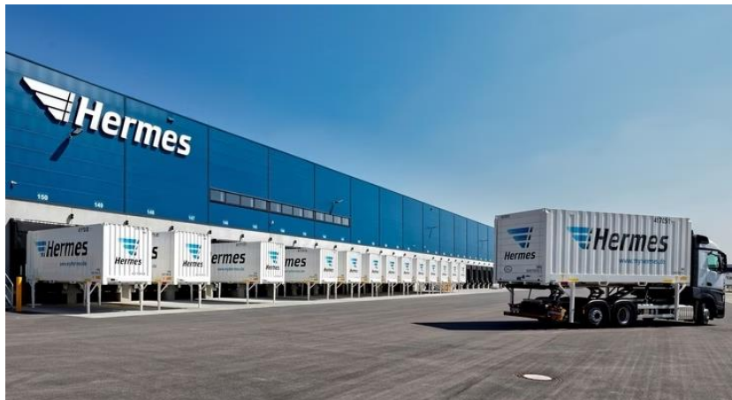
Abbildung 17: Wechselbrücken an einer Umschlagshalle vom Paketdienst Hermes (Pressefoto Hermes)
